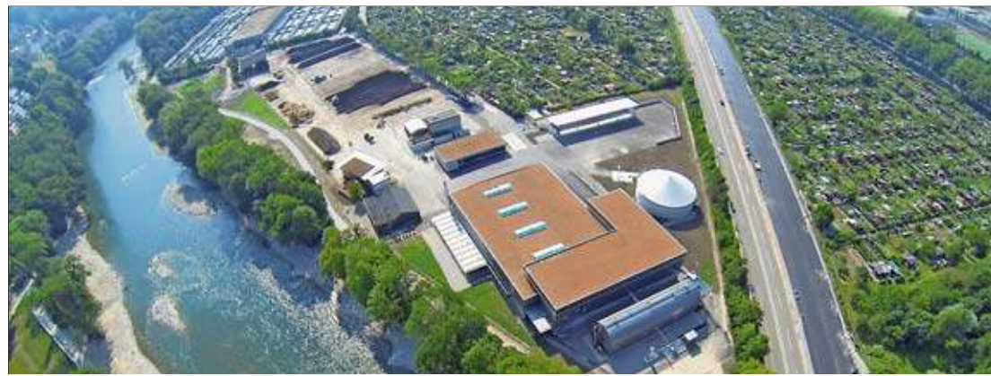
Am 24. August können Interessierte das neue Vergärwerk Werdhölzli besichtigen. Foto: zvg.
