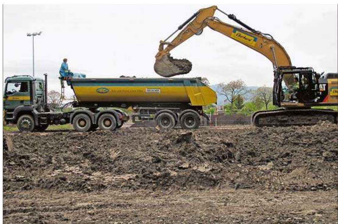
Der Bau des Hochwasserdamms schreitet voran.
